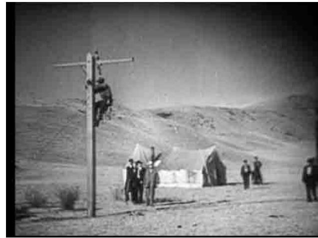
Pose du dernier répéteur téléphonique transcontinental. La première communication entre New-York et San Francisco eut lieu en janvier 1915.
