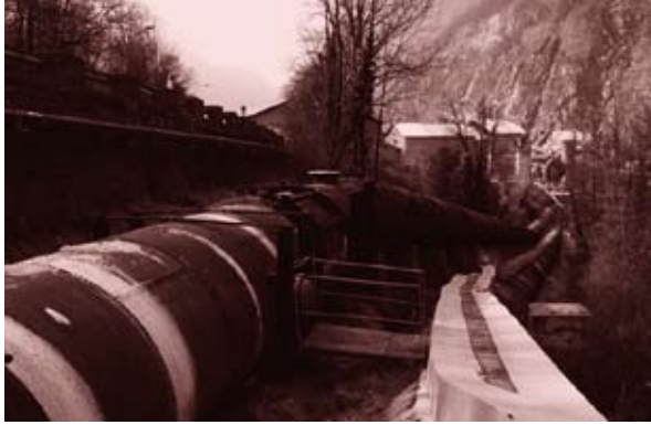
L'usine des Clavaux, à Livet-et-Gavet.
